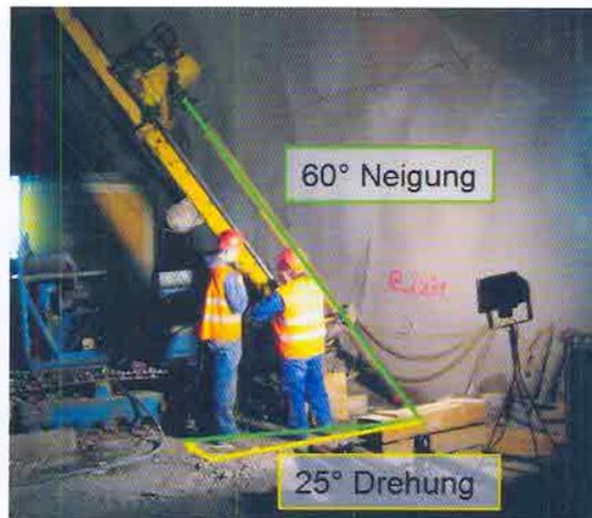
Bild 9. Entnahme von orientierten Kernproben in alpinen Molassegesteinen aus einem Tunnel heraus mittels rechtwinklig zur Schichtung ausgerichtetem Mehrfachkernrohr.
